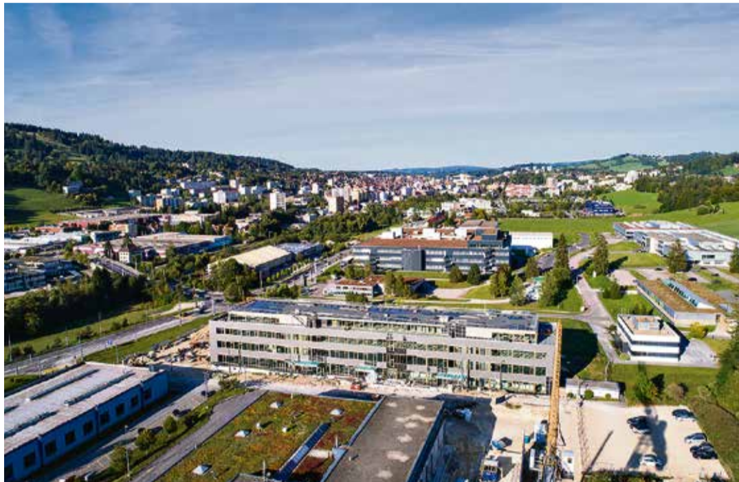
Le nouveau bâtiment, au premier plan, regroupant certaines des entreprises des «Industriels du Sentier» est situé à la sortie ouest de La Chaux-de-Fonds. Il est divisé à 35 millions de francs et sera opérationnel début 2018. (DR)
